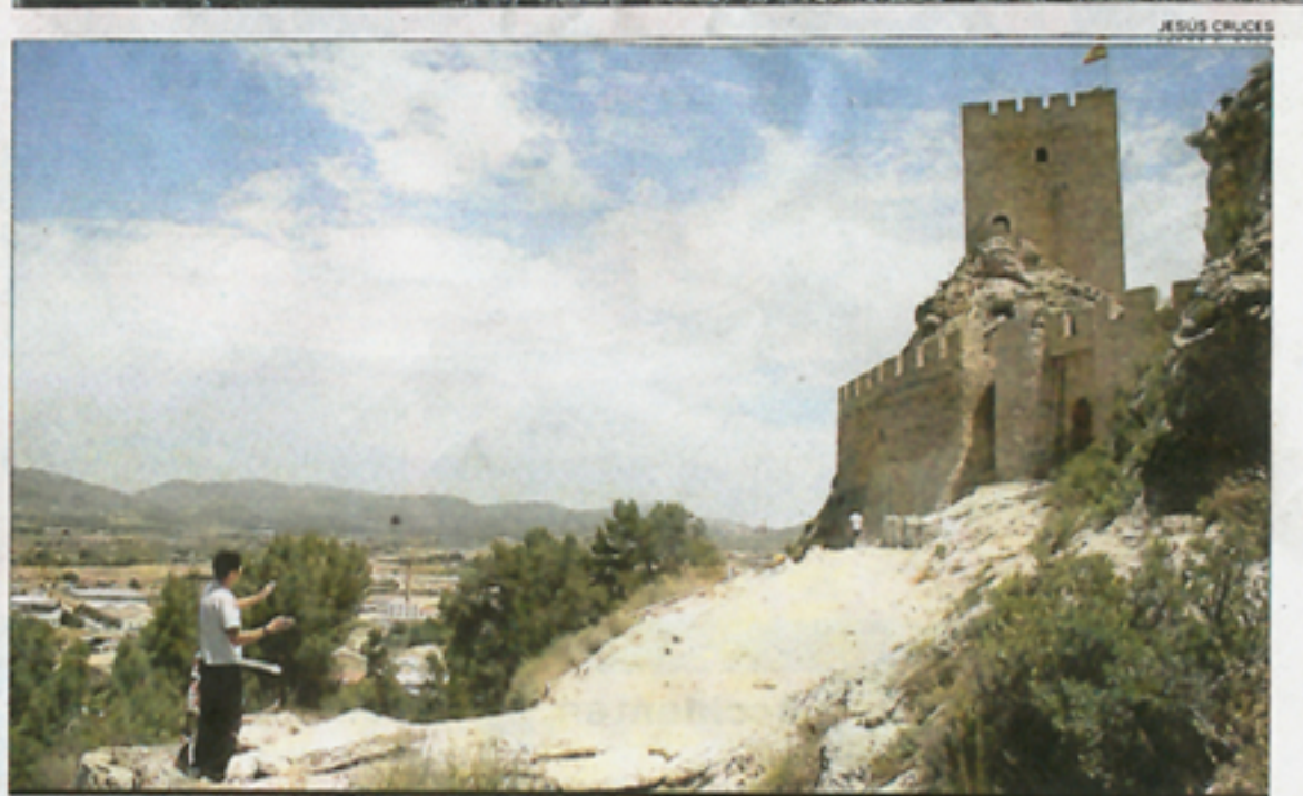
Último tramo de acceso a la fortaleza, donde ya se han iniciado las obras pese a la oposición
